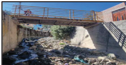
FIGURA N°02: Tramo de la quebrada Tingo Ragra bajo un puente peatonal, mostrando acumulación de residuos y material granular en el lecho, lo que limita el flujo del agua y podría causar desbordes.
