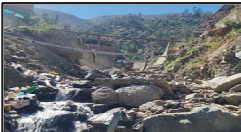
FIGURA N°01: Quebrada con abundante material de arrastre (rocas, escombros) y residuos sólidos, lo que evidencia una descolmatación necesaria y riesgo de obstrucción de estructuras (puentes, tuberías) visibles al fondo.
