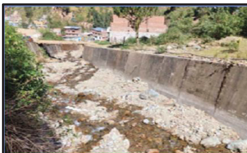
FIGURA N°03: Quebrada con tramo canalizado, pero con el lecho colmatado, presentando gran cantidad de sedimentos y residuos sólidos que requieren limpieza para mantener la capacidad hidráulica.
